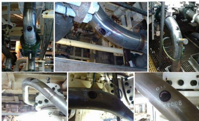
井口管线弯头上安装传感器的范例
